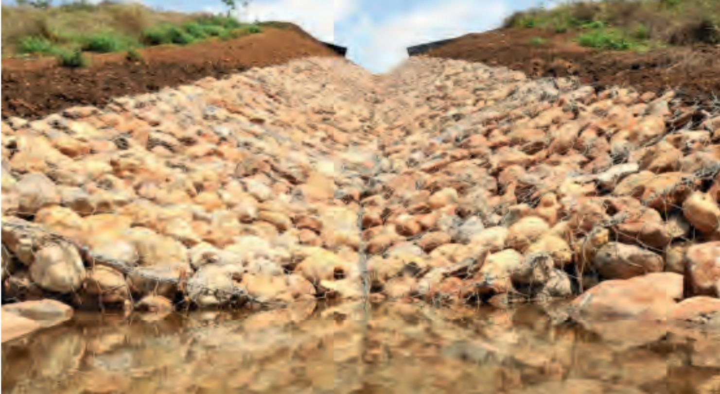
*Canal enrocado de drenaje superficial. Una de las obras de infraestructura requeridas para estabilizar suelos en áreas con fuerte pendiente.*
