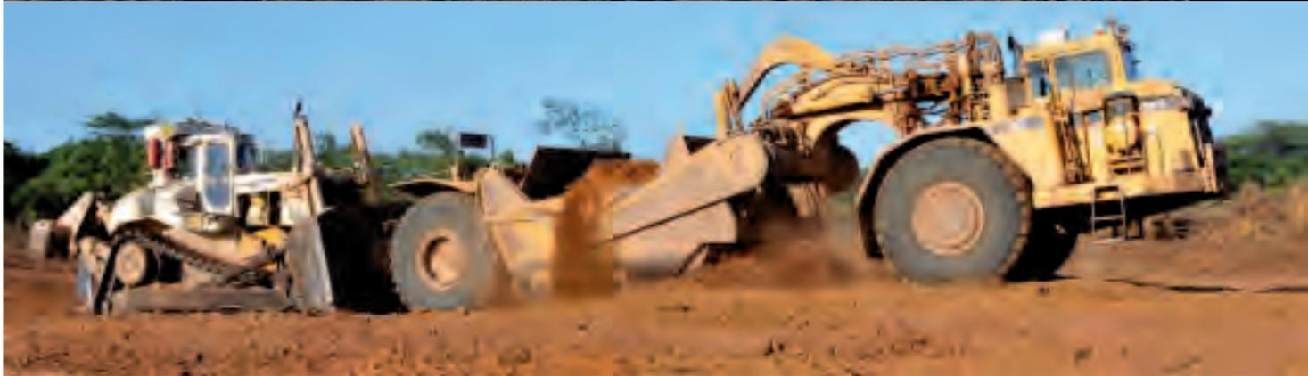
*Arriba, desmonte de la vegetación arbórea con tractores de oruga. Abajo, Operación combinada de tractores de oruga y mototraíllas para la remoción de materiales edáficos y su acarreo hacia los bancos de preservación.*
