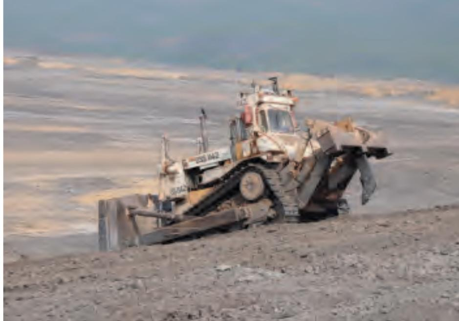
*Botadero Patilla, reconfiguración de taludes mediante cortes y rellenos de material estéril con tractores de oruga.*
