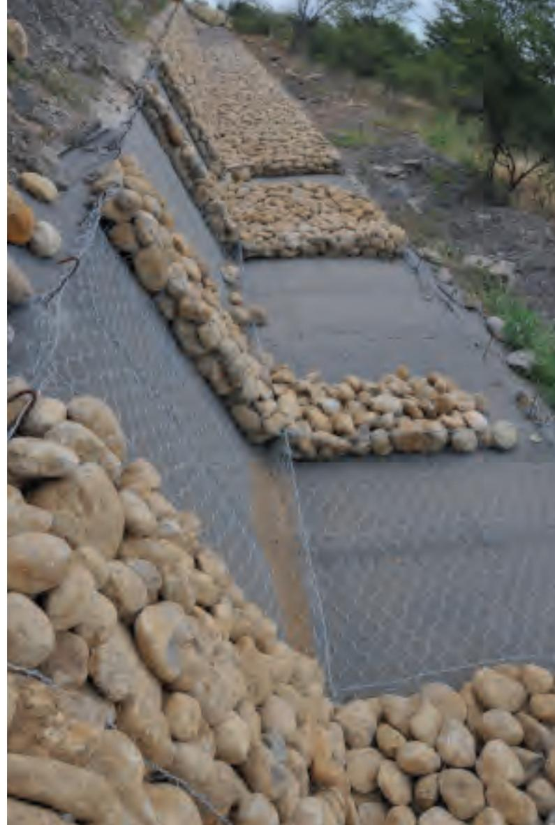
*Estructura de drenaje en construcción; canal en "V", lecho impermeable y paredes laterales revestidas con gaviones aplanados rellenos con rocas.*
