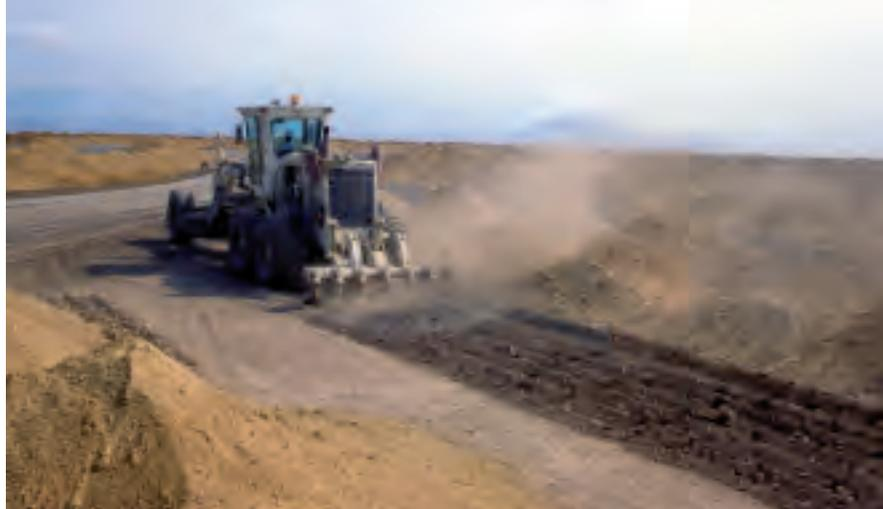
*Manantial nivel 180. Escarificación de la superficie del botadero entre las bandas de descargue del material edáfico.*
