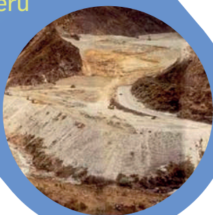
Escombrera Tablachaca Perú
