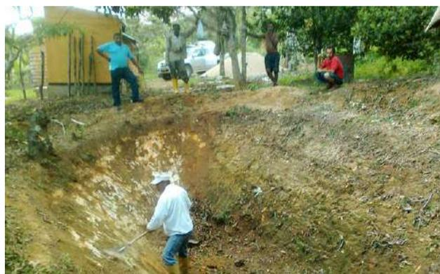
*Ilustración 41. Excavación manual de reservorio*
